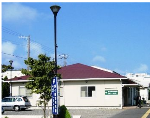
茅ヶ崎市民活動サポートセンター 7.77kW 平成20年度 グリーン電力基金 地域協働プロジェクト
