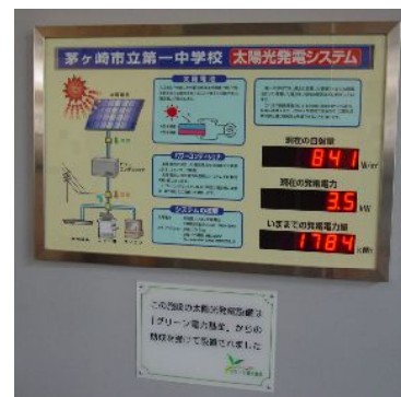
第一中学校体育館 5kW 平成15年度 グリーン電力基金 環境教育目的用
