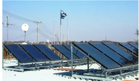
川崎フロンターレ麻生クラブハウス太陽熱温水器
